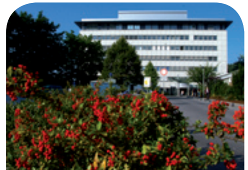
Ev. Krankenhaus Herne
